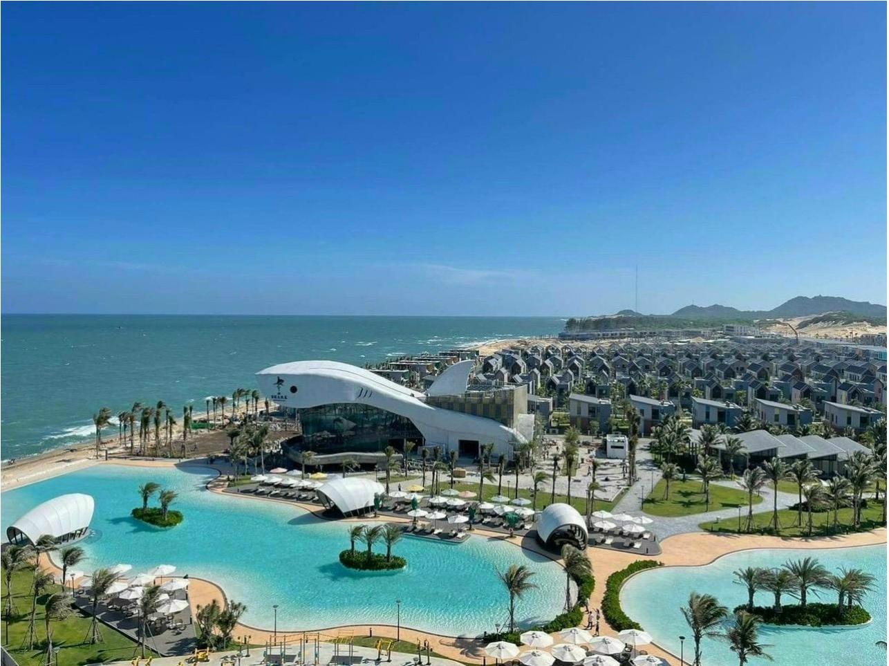
Các nhà hàng thuộc Nova FnB tại NovaWorld Ho Tram chuẩn bị đưa vào vận hành (Ảnh thực tế tháng 04/2022)
